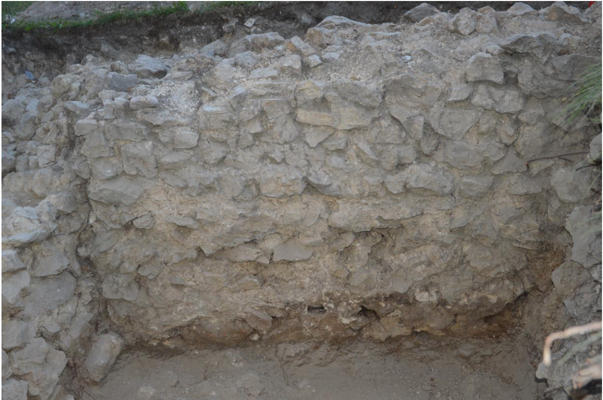
7. SE-5 fal nyugat felől. Jól megfigyelhető a hozzáépítés SE-12 falhoz, ill. a falsík magasságának közepe táján az alapfal és a felmenőfal elválása
